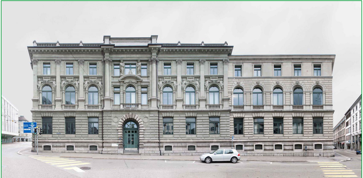
Abbildung 3: Hauptfassade an der Schützengasse 1
