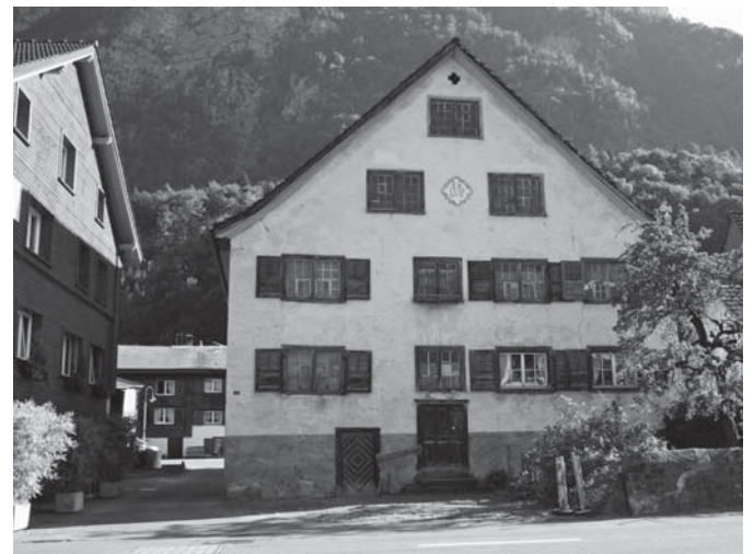
Südfassade des Wohnhauses Lindengasse 2 in Berschis (Bild: Kantonale Denkmalpflege)
