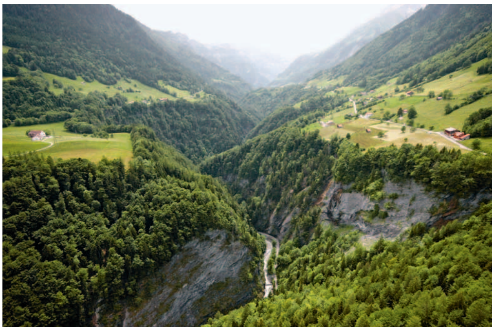
Die Taminabrücke soll die Pfäferser Talseite (links) und die Valenser Talseite (rechts) verbinden.
