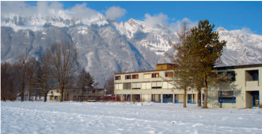
Landwirtschaftliches Zentrum SG, Salez: Die baulichen und betrieblichen Verhältnisse genügen nicht mehr.
