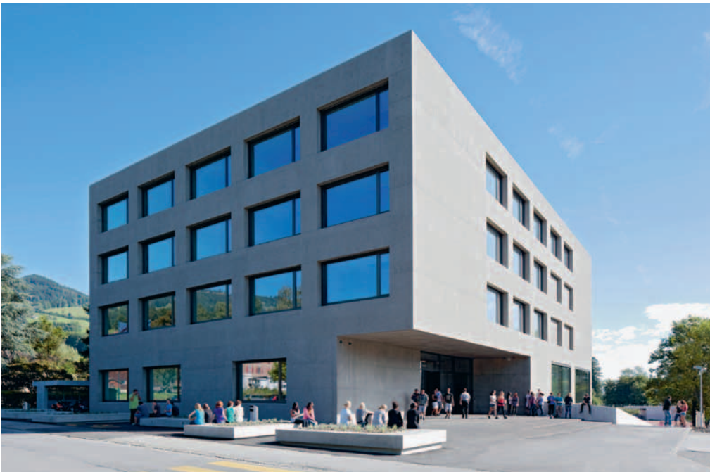
Das neue Schulhaus für das Berufs- und Weiterbildungszentrum Rorschach-Rheintal in Altstätten besticht nicht nur durch seine äussere Erscheinung, sondern auch durch den zweckmässigen und modernen Innenausbau.
