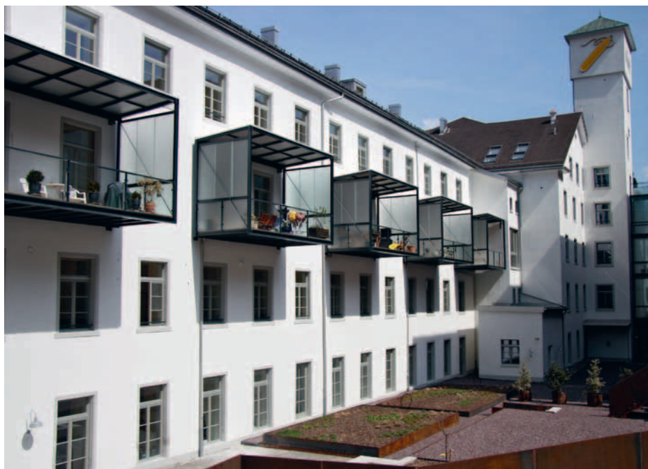
Die alte Spinnerei Murg – ein Beispiel für denkmalpflegerisch vorbildlich renovierte und umgenutzte Bauten.
