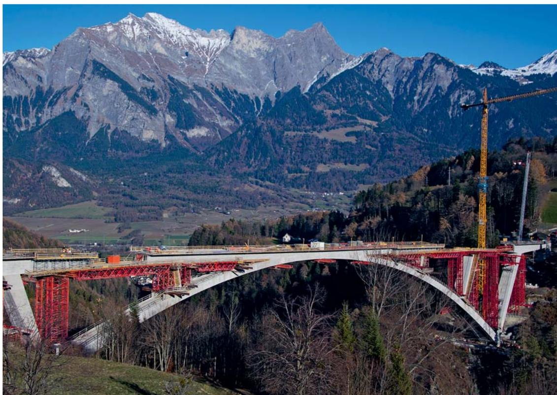
Nach dem Bogenschluss im März 2015 wurde mit dem Bau der 417 Meter langen Fahrbahn der Taminabrücke begonnen. (Foto: Fetzer, Bad Ragaz)
