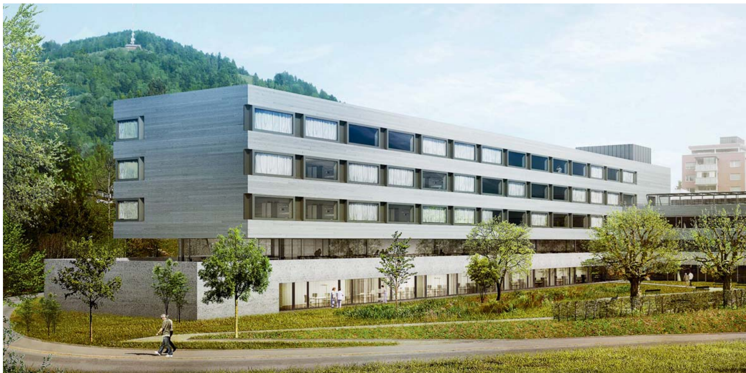
Im dreistöckigen Erweiterungsbau für das Spital Wattwil werden künftig die Bettenstationen, das neue Restaurant, die Physiotherapie und auf dem Dach der Helikopterlandeplatz eingerichtet.
