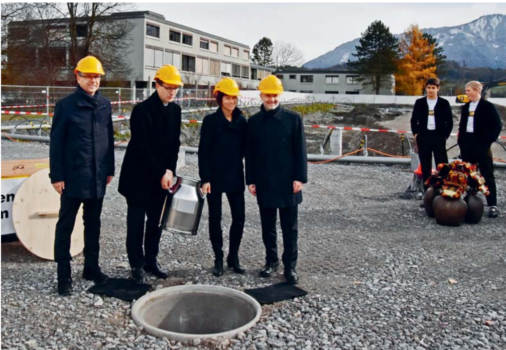
Die Regierungsräte Marc Mächler und Stefan Kölliker, Regierungsrätin Heidi Hanselmann sowie Markus Hobi, Leiter des LZSG Salez, platzierten verschiedene Gegenstände in einer Milchtanz, die im Fundament des Neubaus einbetoniert wurde.
