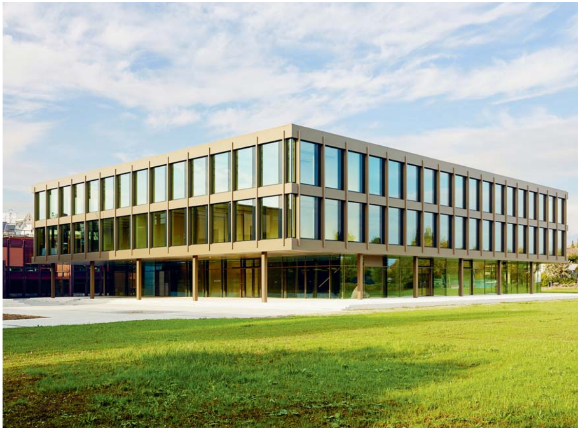
Der Neubau des Forschungszentrums löst bisherige Provisorien ab und trägt dem zusätzlichen Platzbedarf Rechnung. © Seraina Wirz
