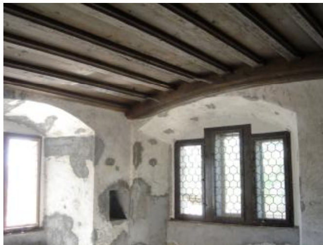
Schloss Feldegg, Jonschwil: Sanierung der gotischen Stube (Foto: Jürg Scherrer, Bauherr)
