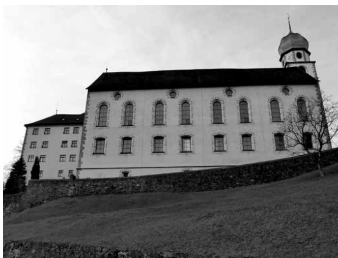
Klosterkirche Pfäfers, ostseitige Dachfläche. (Bild: zVg Kantonale Denkmalpflege)
