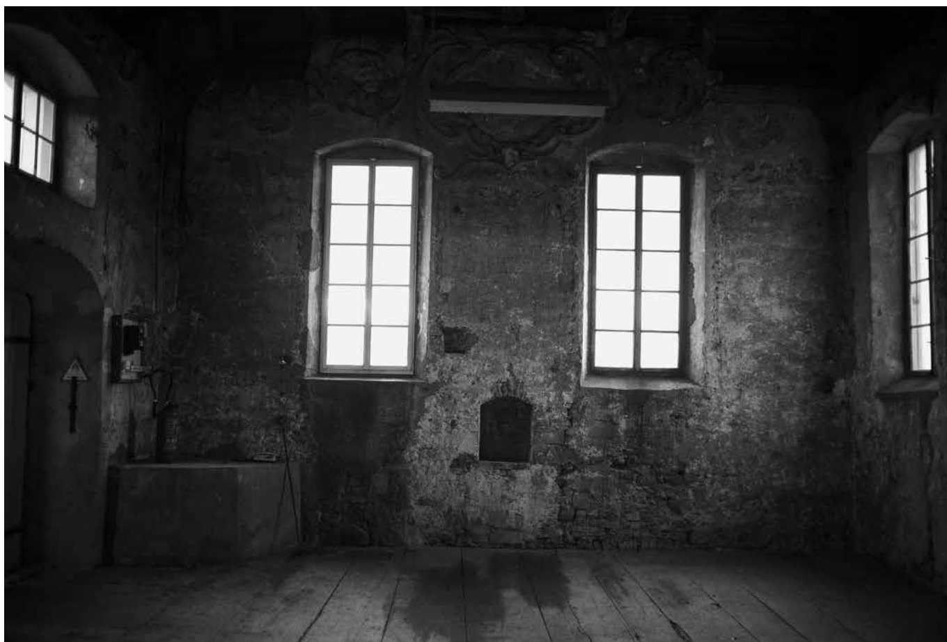
Die Dienerschaftskapelle soll als spezieller, multifunktional sowie sakral nutzbarer Raum das Angebot im Hof zu Will ergänzen. (Bild: Marcus Gossolt, zVg Stiftung Hof zu Wil)
