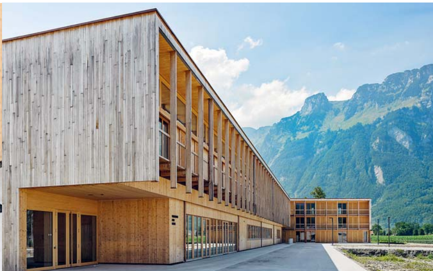
Mit dem neuen Hauptgebäude am Landwirtschaftlichen Zentrum St. Gallen in Salez erhält die St. Galler Landwirtschaft eine zeitgemässe Infrastruktur für Bildung und Beratung.
