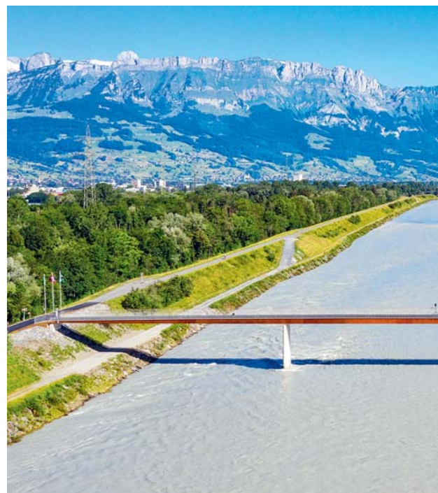
Die neue Velobrücke zwischen Buchs und Vaduz schafft eine sichere und direkte Verbindung für den Fuss- und Veloverkehr (Daniel Schwendener, Agglomeration Werdenberg-Liechtenstein).
