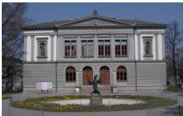
Der Kunklerbau besticht durch die Qualität der Ausstellungsräume. Die Möglichkeiten der Erweiterung sind aber begrenzt. (Foto: Amt für Kultur)
