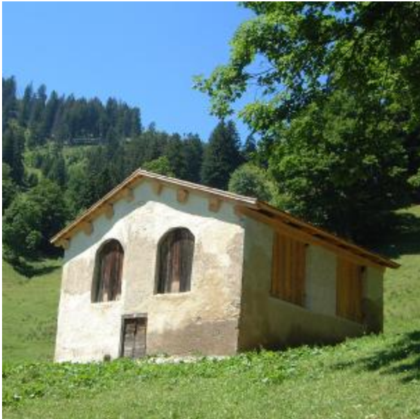
Klinik Bad Pfäfers, Stall untere Diätsche, Pfäfers (Foto: Kantonale Denkmalpflege)
