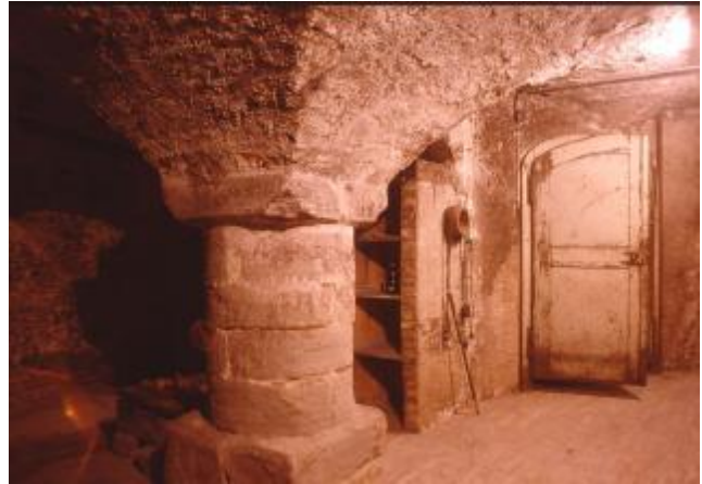
Kellergewölbe vor der Restaurierung, Schloss Heerbrugg (Foto: Kantonale Denkmalpflege)
